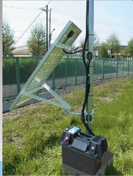
バッテリー収納BOXは地上設置タイプとポール取り付けタイプの2種類から設置状況でご選択下さい
